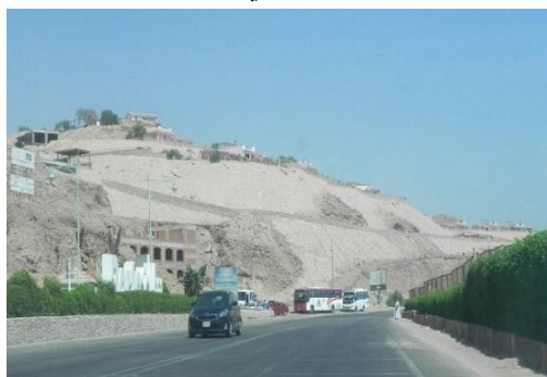
صورة (٤) المباني أعلي منحدرات، بورتو السخنة المصدر : الزيارة الميدانية : ٢٠١٦/٠٩/١٣ م
