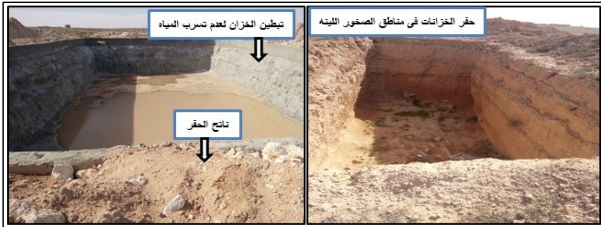
صورة (٤): توضح نموذج للآبار في المنطقة
